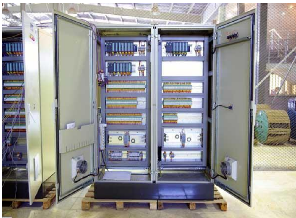
شکل (۵-۵): نمونه ای از تابلوهای کنترل پیاده سازی شده توسط شرکت ندا (تجهیز شده توسط شرکت ندا)
