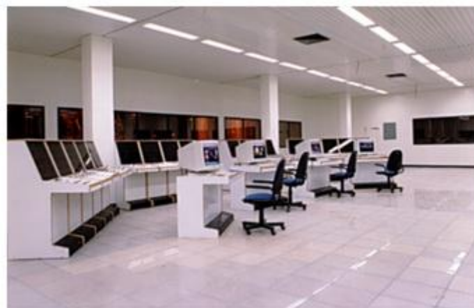
شکل (۵-۳): اتاق کنترل شرکت ذوب آهن اصفهان (تجهیز شده توسط شرکت ندا)
