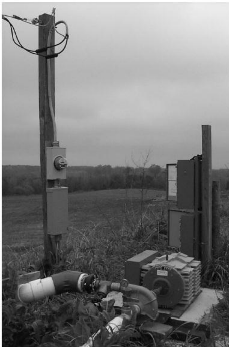
شکل (۹-۷): موتور تکفاز نوع written-pole مورد استفاده جهت آبیاری به همراه پمپ آب، کنتور برق، و تابلو
